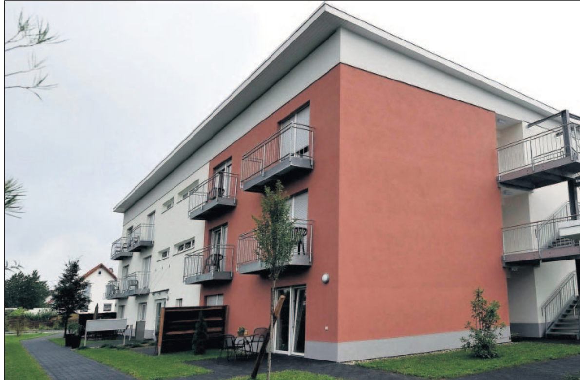
Das größere der beiden Wohnheime für psychisch Behinderte im Eulerweg in Lambsheim. Mitten im Wohngebiet, nahe dem Bahnhof und am Rande der Natur sollen hier 16 Menschen zu einem eigenständigen Leben zurückfinden.
