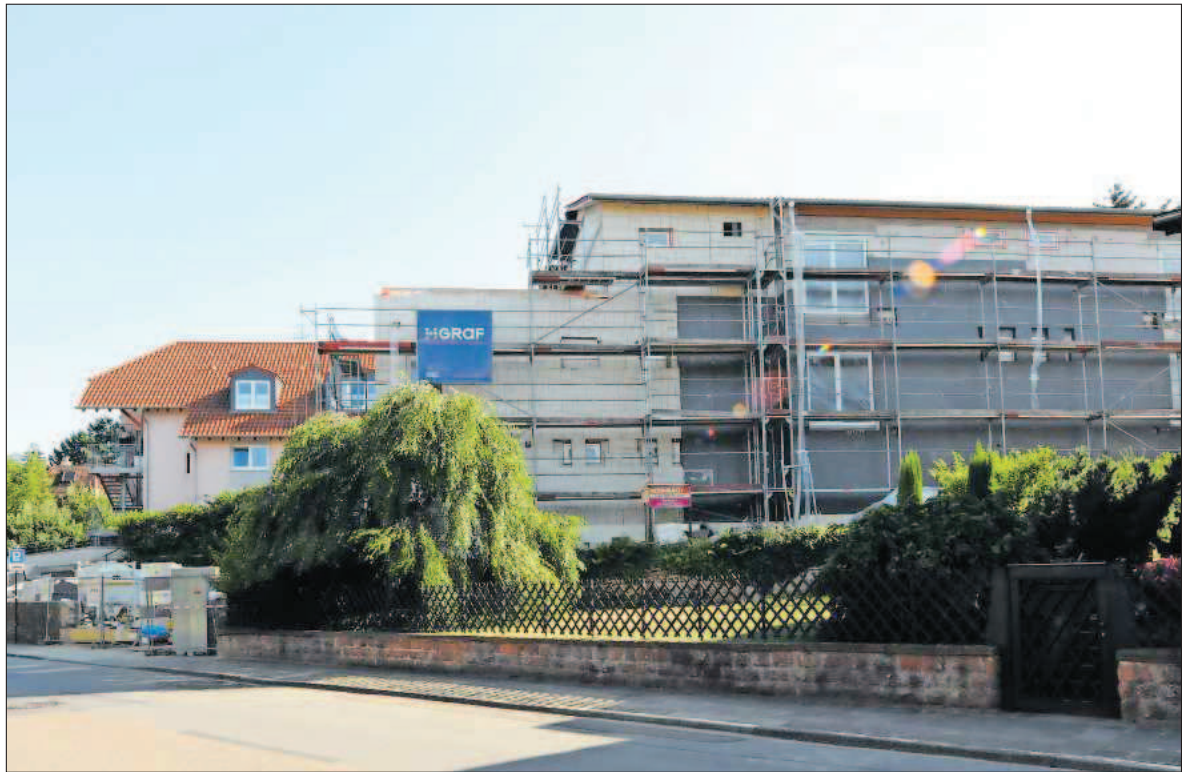
Ein neuer Gebäudekomplex des Masurenhofs entsteht derzeit in der Weinstraße Süd.
